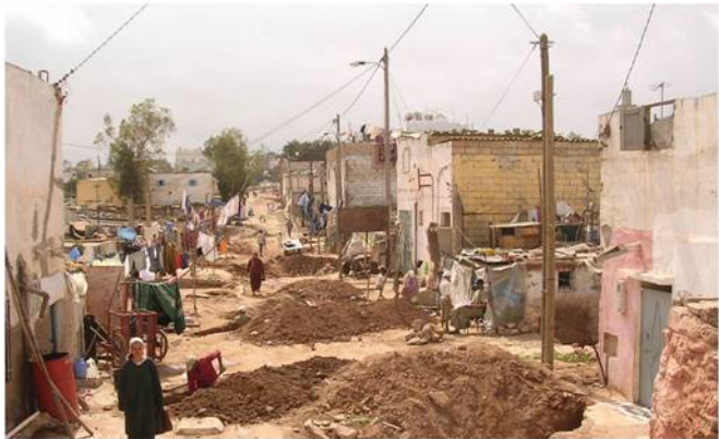
Mise en oeuvre des réseaux et voiries
