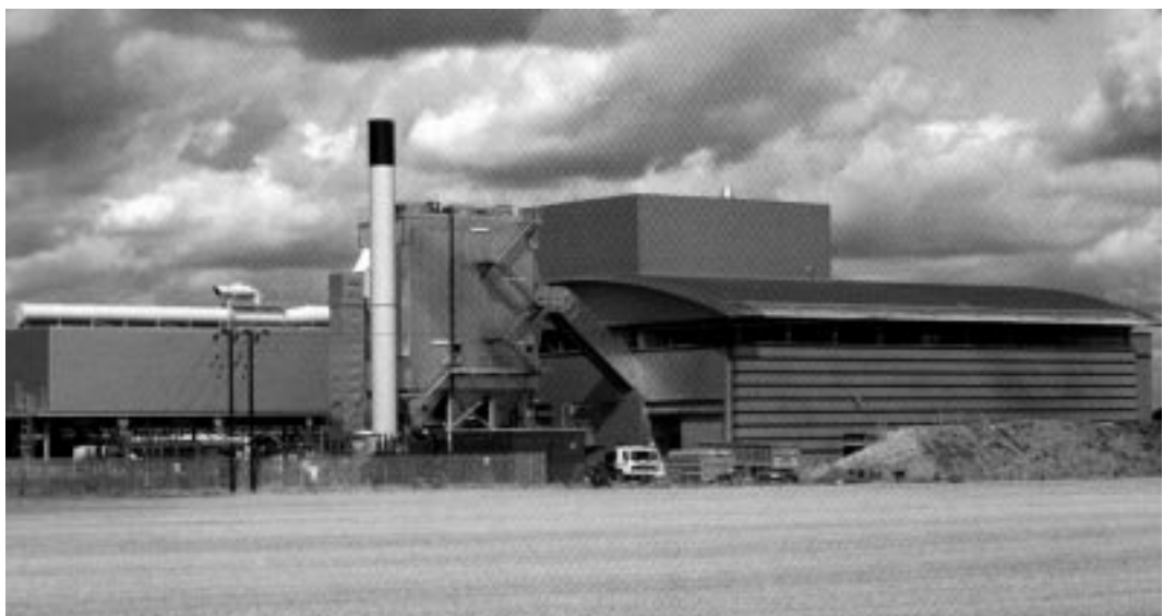
Centrale de production d'électricité à partir de fumier de volaille (Eye/Suffolk, 12,7 MW)
